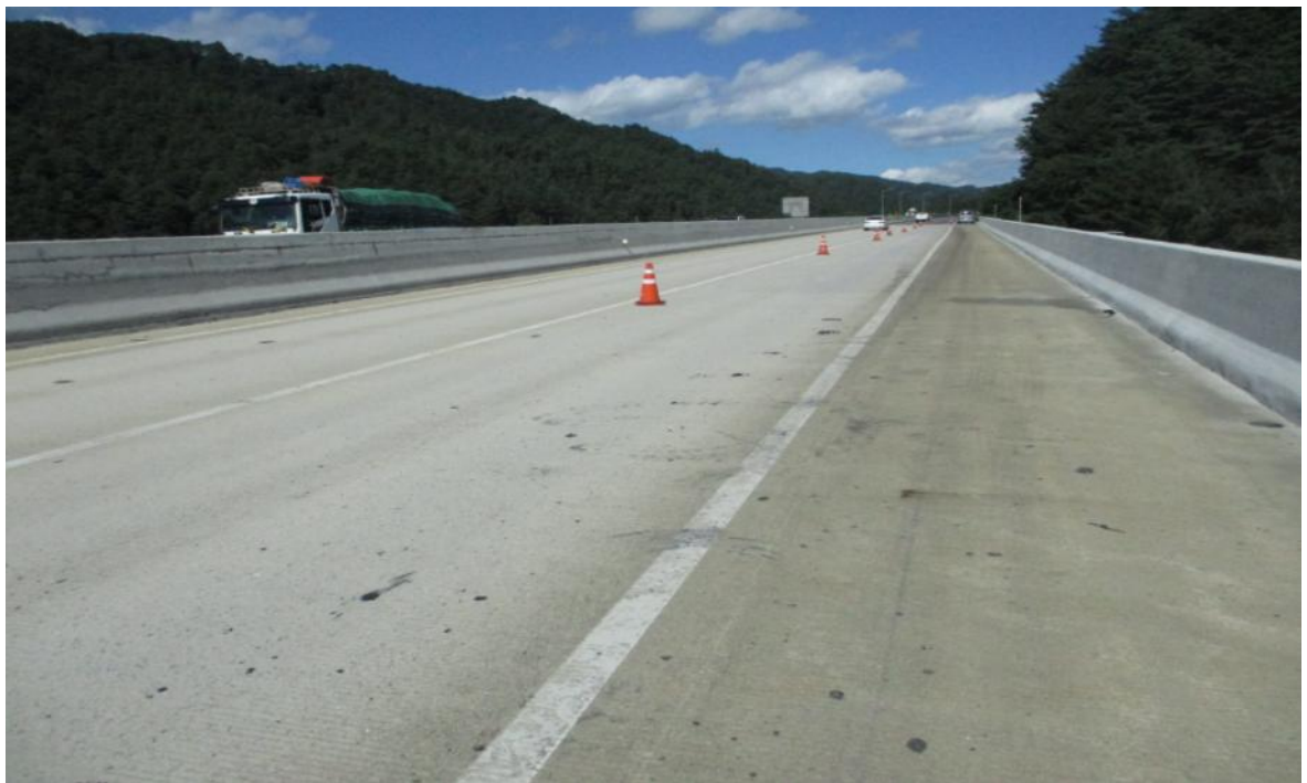
교량 상부 전경
