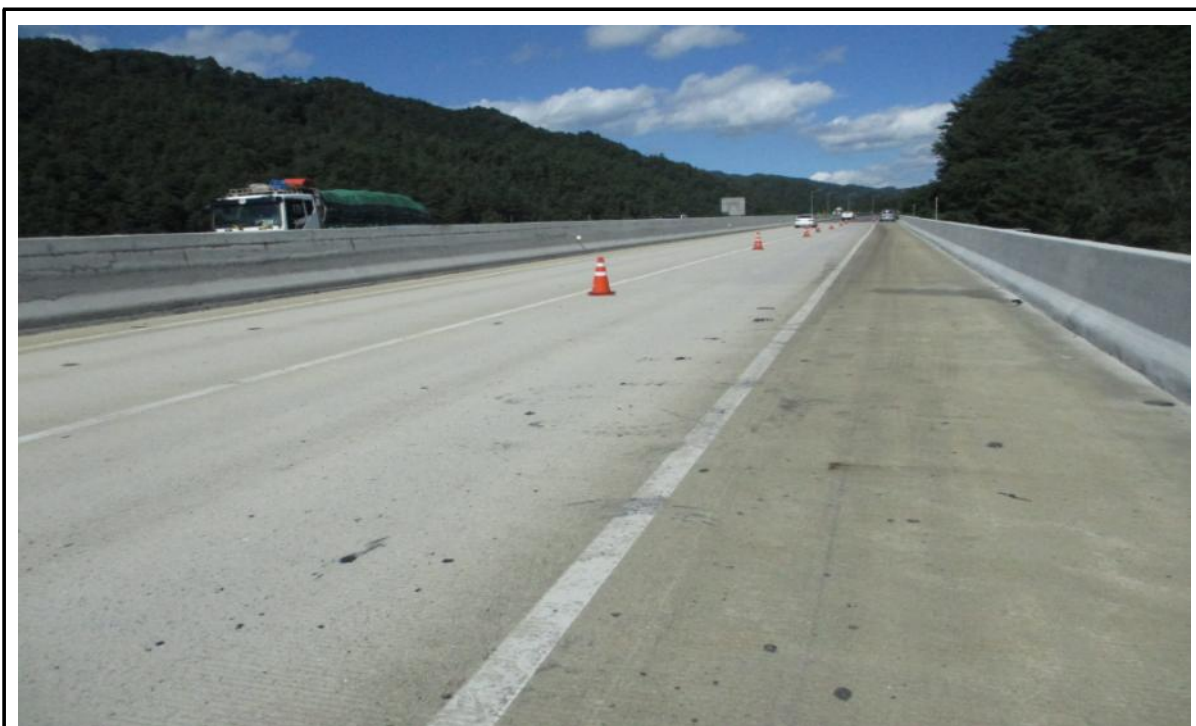
교량 상부 전경
